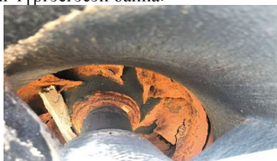
Зураг 1. Эвдэрсэн насосноос мод гарч ирсэн байдал
