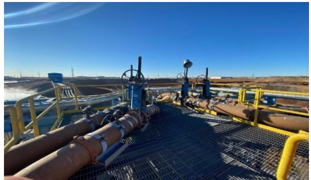
Зураг-9. Хаягдал өтгөрүүлэгчийн хоослож байгаа, хоослох хаалт болон бага нягттай шингэн хаягдал материалыг хаягдлын далан руу тэжээсэн байдлыг харуулав.
